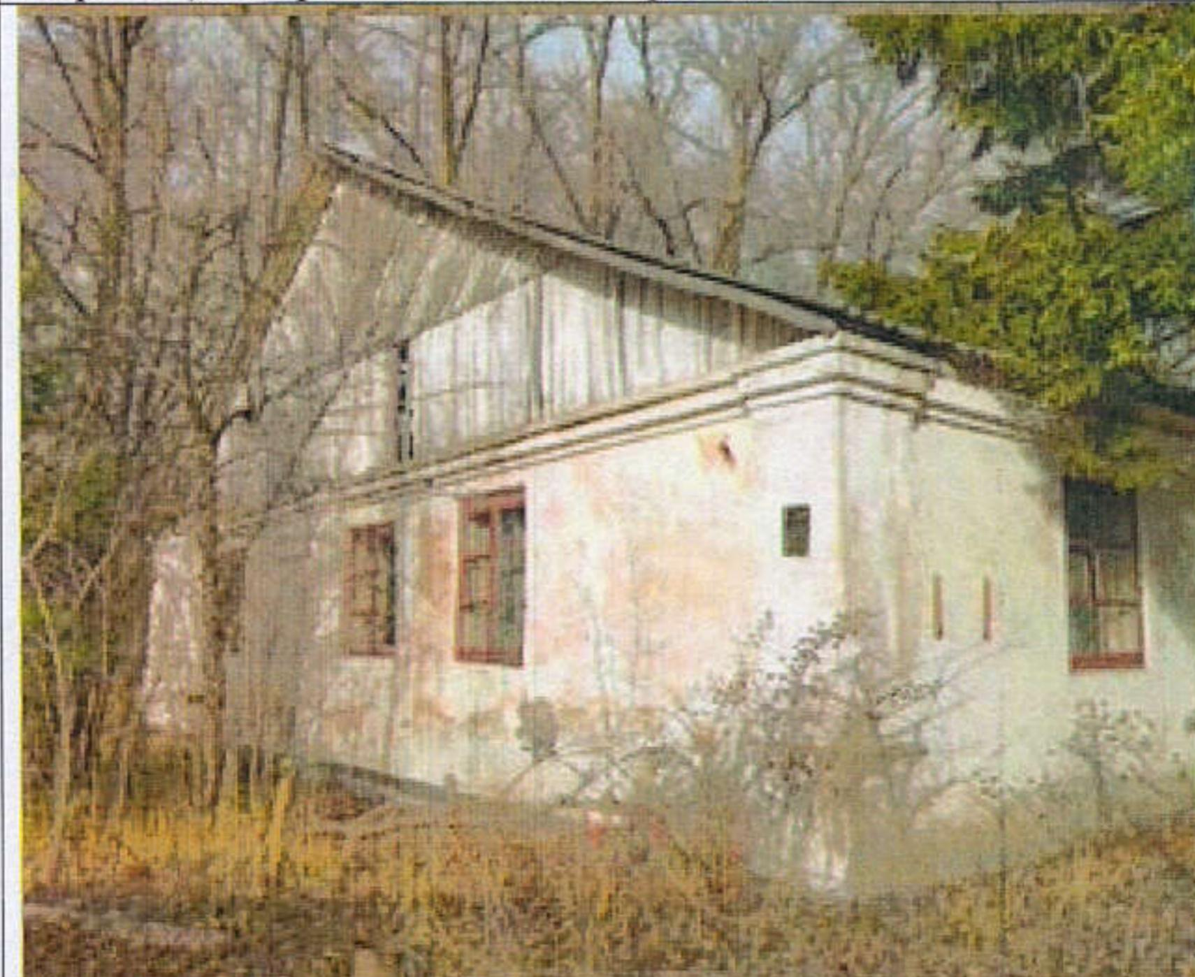
Начало 1920-х. Габариты в плане и высотные отметки (одноэтажное строение габаритами 16,5x34 м.). Материал и конструкции наружных стен (керамический кирпич и блоки). Первоначальные фасады
