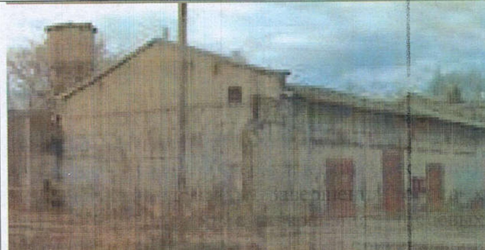
Начало 1920-х. Габариты в плане и высотные отметки (одноэтажное строение габаритами 14x32 м.). Материал и конструкции наружных стен (материал: керамический кирпич). Первоначальные фасады. Здание является окончанием несохранившегося барака общей длиной 327 м.
