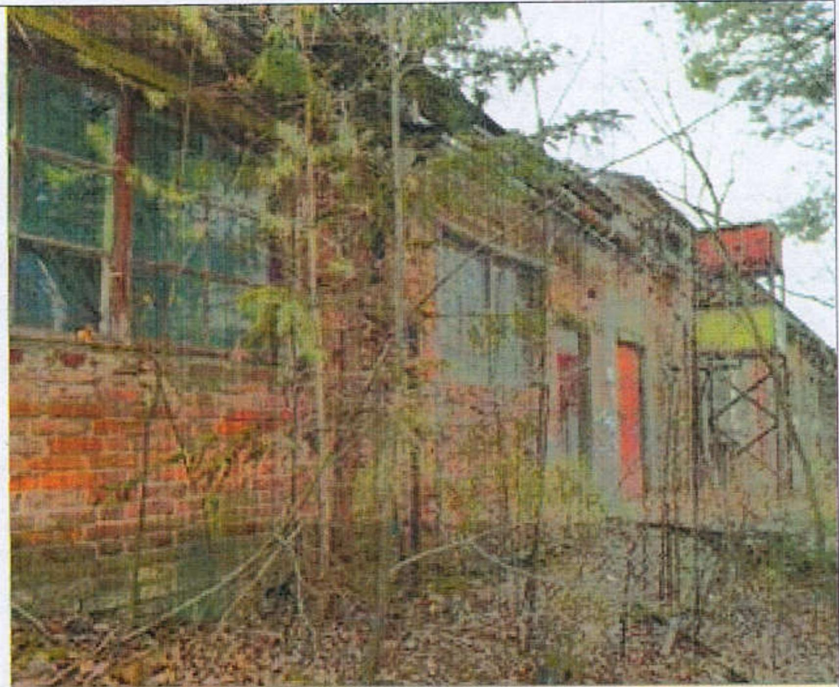
Начало 1920-х. Габариты в плане и высотные отметки (одноэтажное строение габаритами 18x58 м.). Материал и конструкции наружных стен (материал: керамический и силикатный кирпич, цоколь из каменного бута). Первоначальные фасады. Отсутствует до 25% от оригинальной длины здания в крайней части с южной стороны сохранились фундаменты
