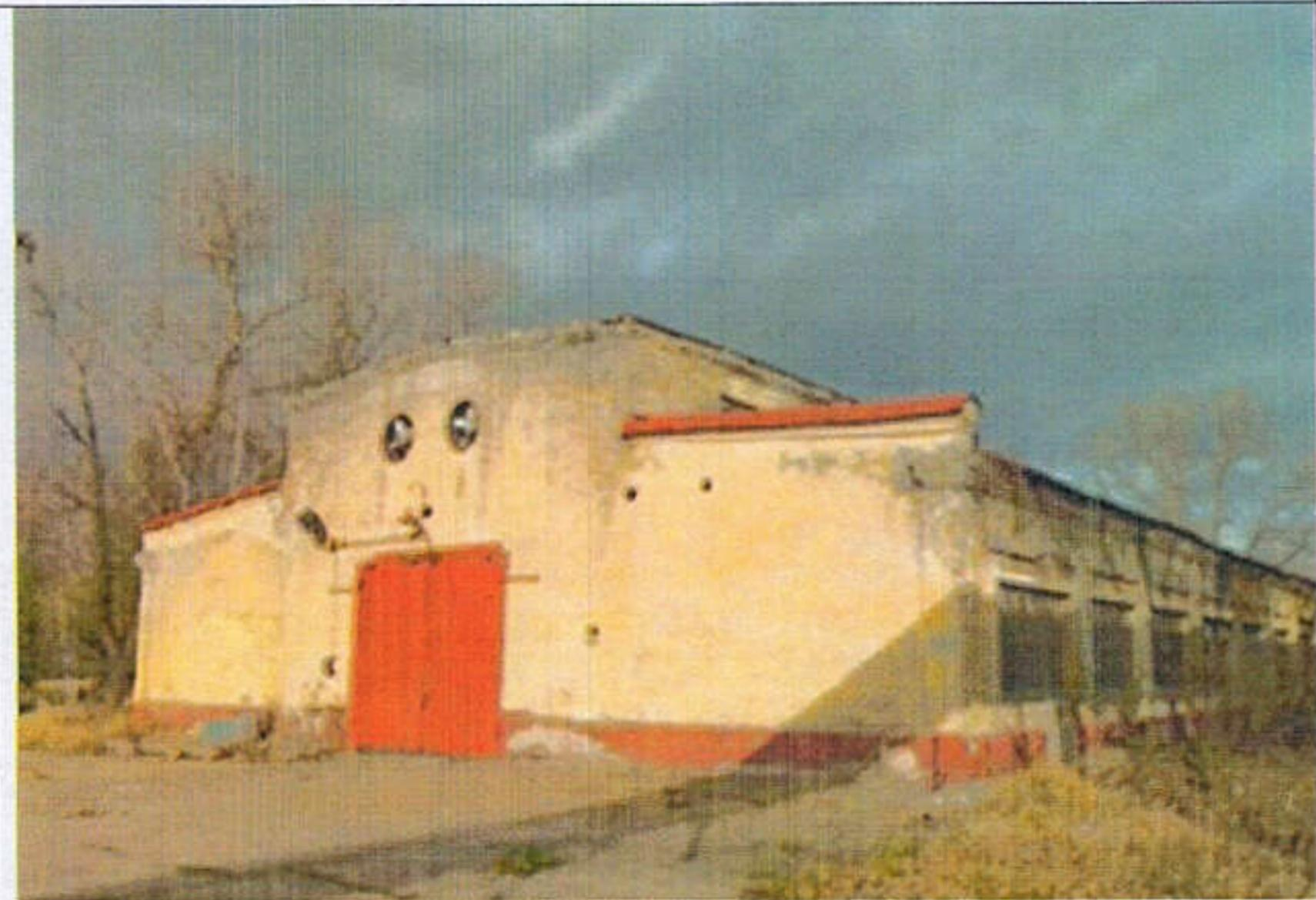
Середина 1930-х гг.. Габариты в плане (трёхпролётное Г-образное в плане строение габаритами 26,5x56 м.). Высотные отметки (боковые части одноэтажные, средняя часть имеет высокий двухсветный объём). Материал и конструкции наружных стен (силикатный кирпич). Первоначальные фасады
