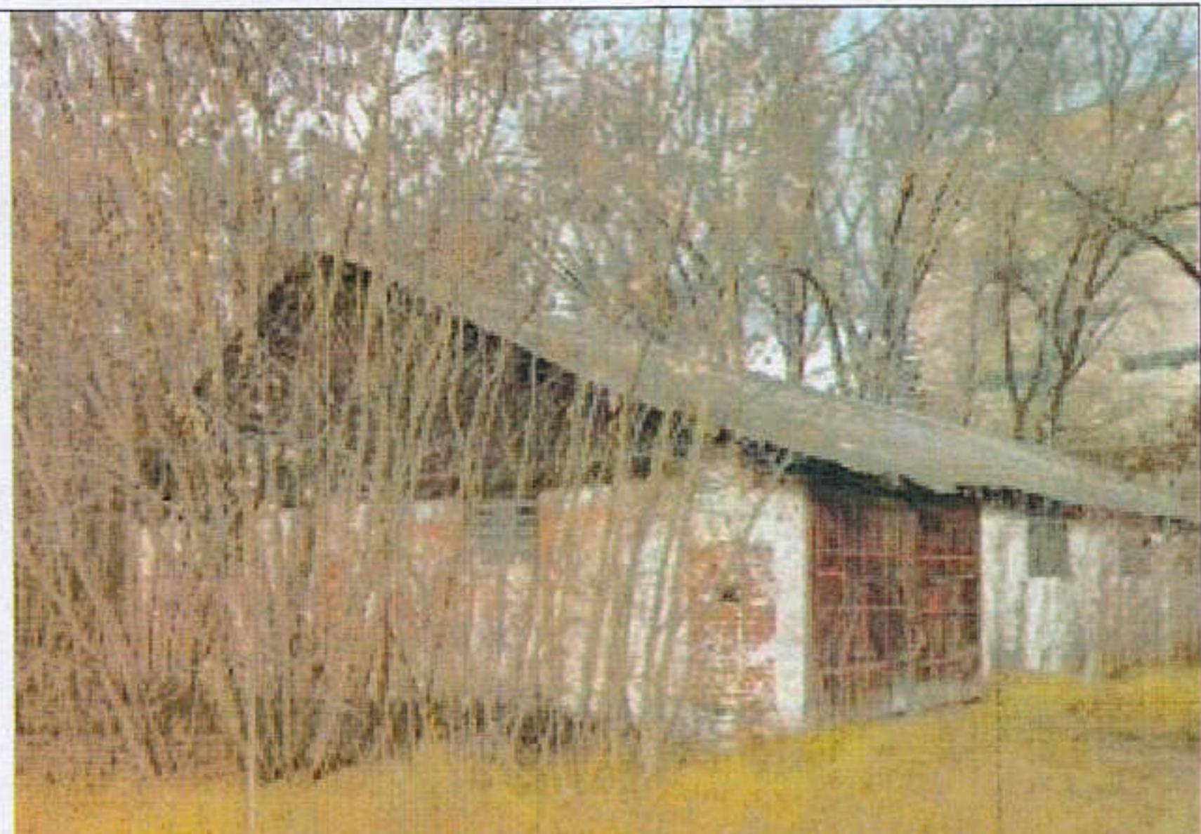
Начало 1920-х. Габариты в плане и высотные отметки (одноэтажное строение габаритами 16,5x34 м.). Материал и конструкции наружных стен (керамический кирпич и блоки). Первоначальные фасады
