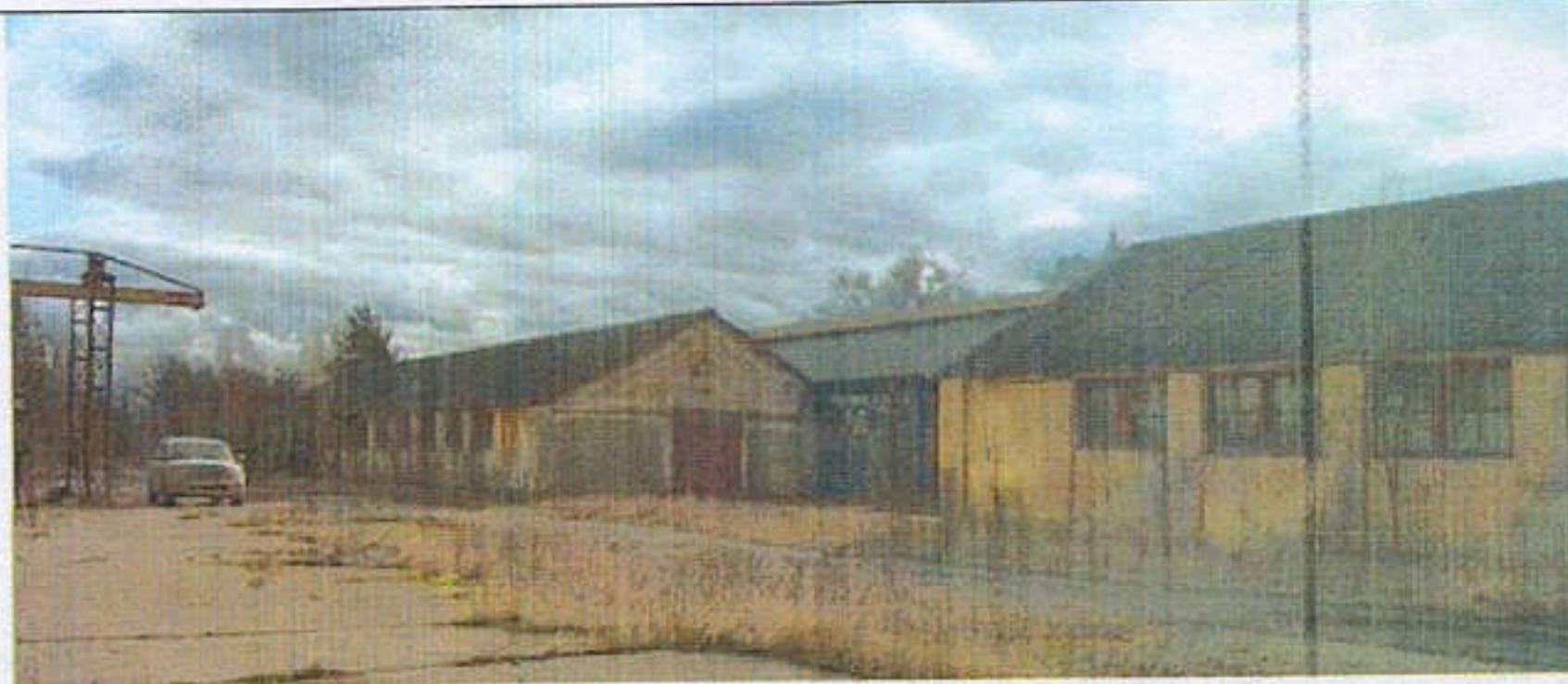
Начало 1920-х. Габариты в плане и высотные отметки (одноэтажное строение габаритами 14x108 м.). Материал и конструкции наружных стен (материал: керамический кирпич). Первоначальные фасады. Завершения торцевых фронтонов, утрачены завершения торцевых фронтонов, отсутствует до 18% от оригинальной длины здания в средней части
