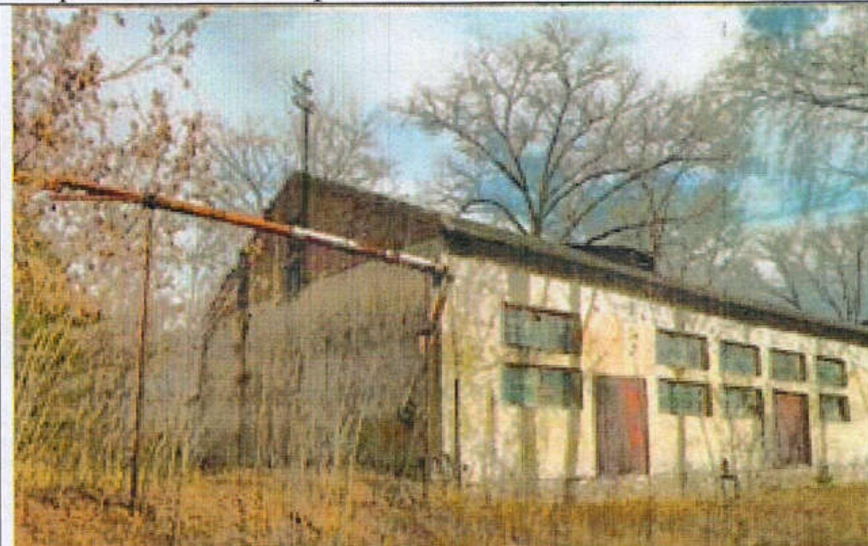
Начало 1920-х. Габариты в плане и высотные отметки (одноэтажное строение габаритами 14x62 м.). Материал и конструкции наружных стен (материал: керамический и силикатный кирпич; цоколь из каменного бута). Первоначальные фасады
