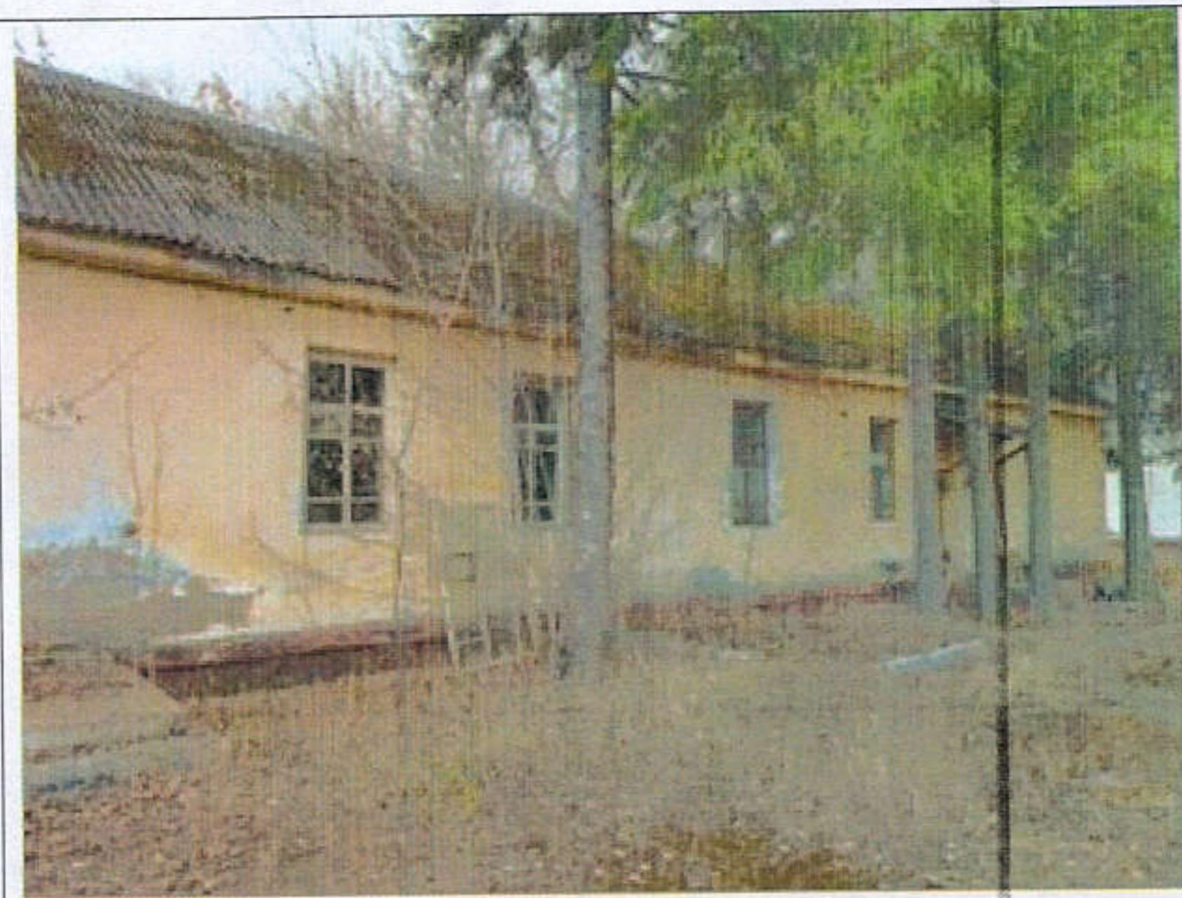
Середина 1930-х. Габариты в плане и высотные отметки (одноэтажное прямоугольное здание с двускатной крышей размерами в плане 9x23 м.). Материал и конструкции наружных стен. Первоначальные фасады
