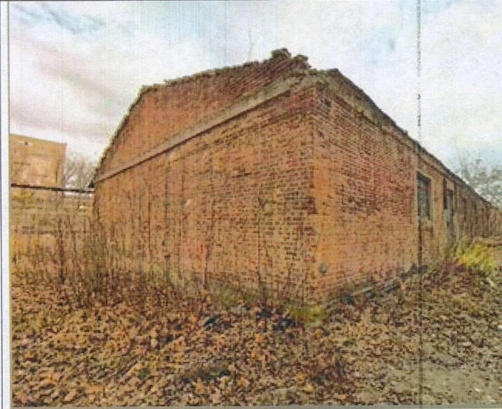
Начало 1920-х. Габариты в плане и высотные отметки (одноэтажное строение габаритами 18x80 м.). Материал и конструкции наружных стен (материал: керамический и силикатный кирпич, цоколь из каменного бута). Первоначальные фасады
